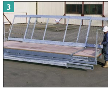
Mise en place des fermetures.
